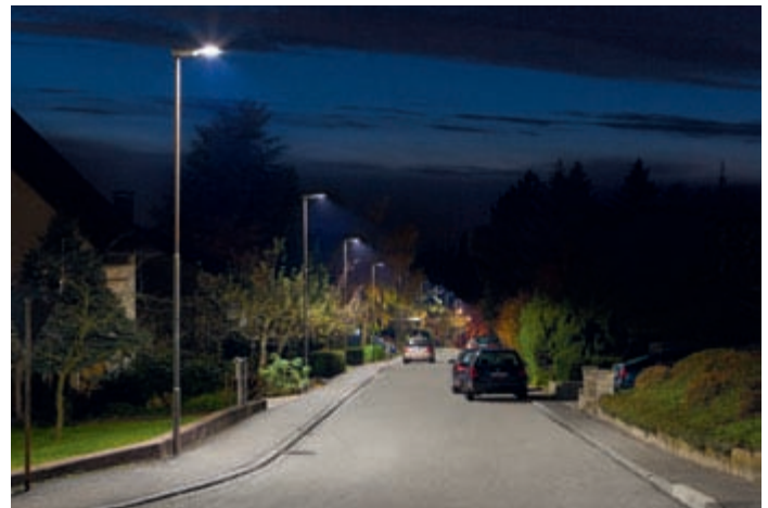
Die Schillerstraße nach der Sanierung
