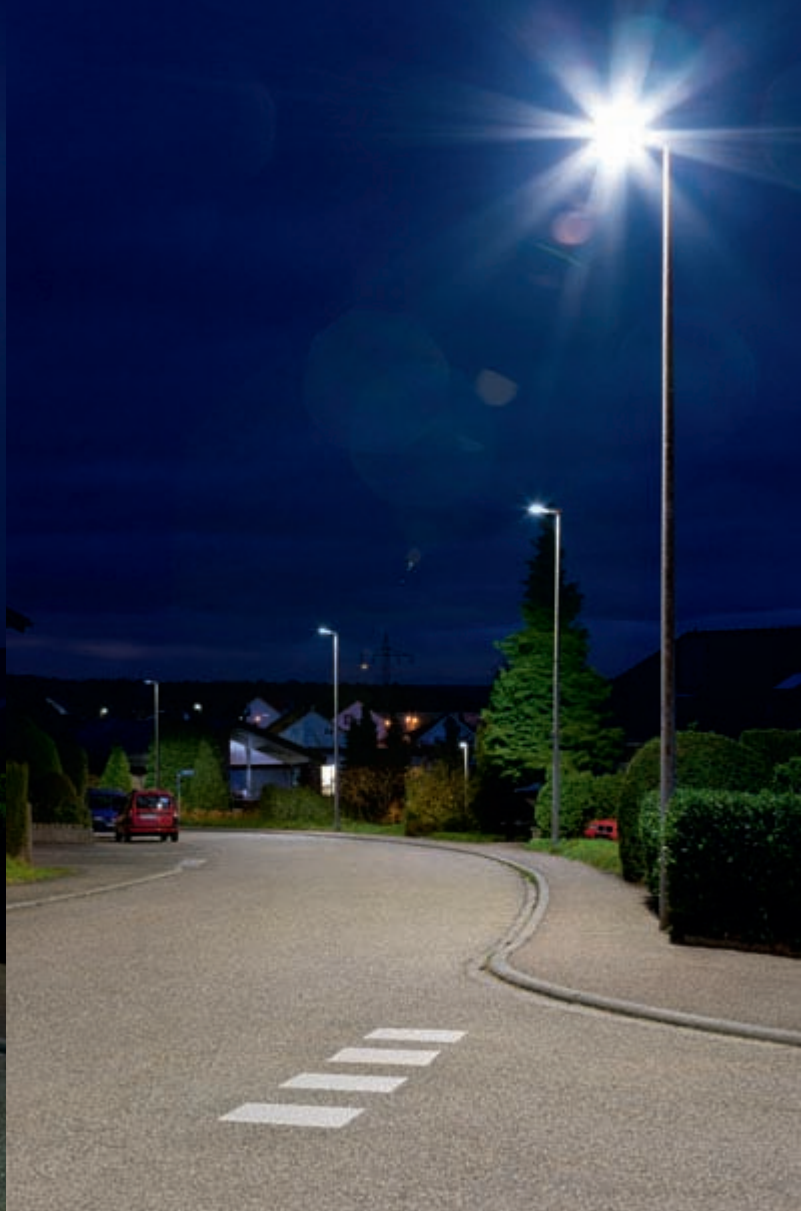
Sonnenbühl nach der Sanierung mit SpeedStar LED-Leuchten von Philips
