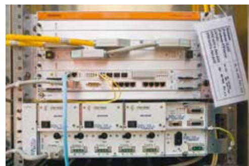
Innenleben eines Multifunktionsgehäuses
