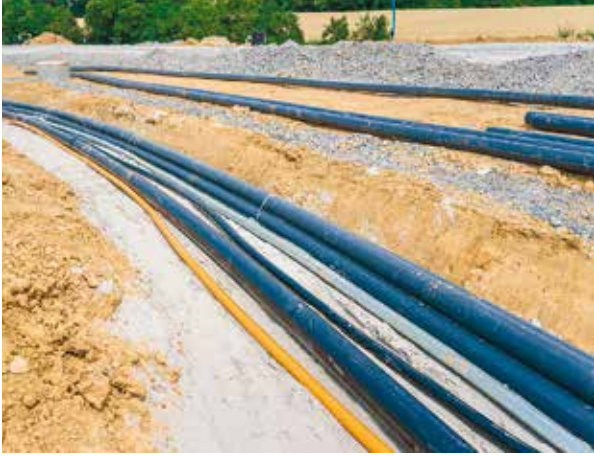
Mitverlegung von Leerrohren bei anstehenden Tiefbauarbeiten
