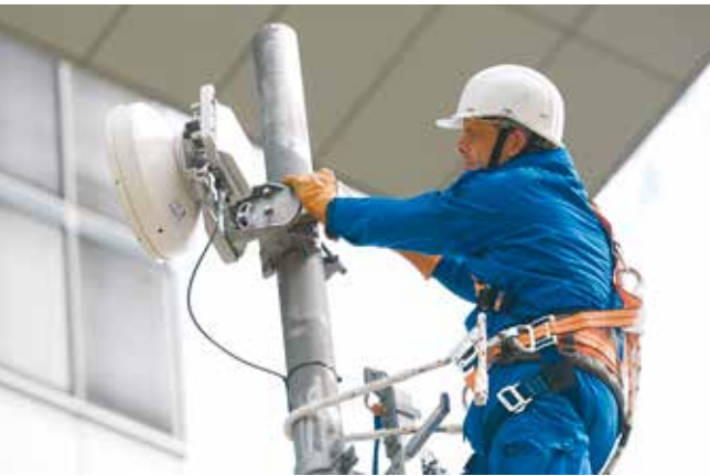
Aufbau einer modernen LTE-Mobilfunkanlage
