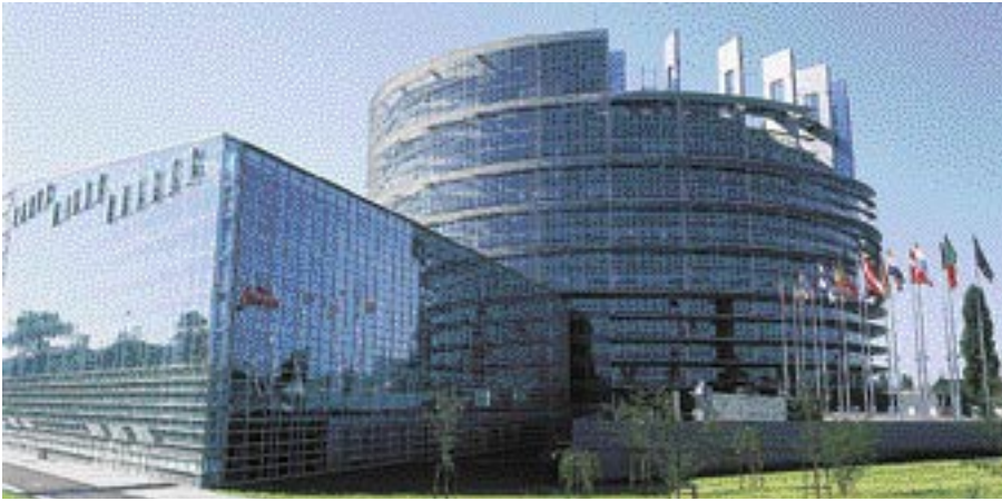
Hinter diesen Mauern werden die Entscheidungen getroffen, die für die deutschen Kommunen von immer größerer Bedeutung werden: Gebäude des EU-Parlaments in Straßburg
