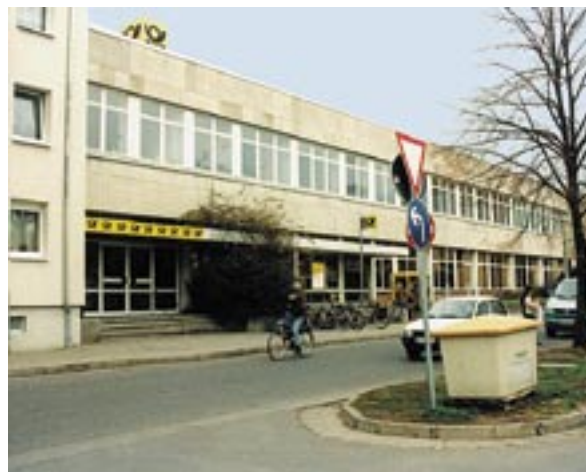
Hauptpost Lützen vor der Baumaßnahme...
