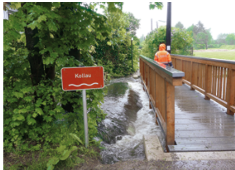
Hochwasser an der Kollau im Norden Hamburgs
