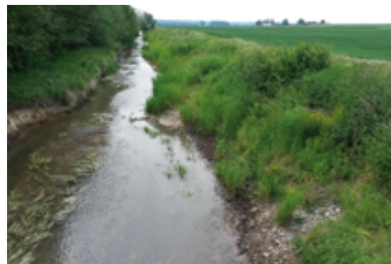
Untersuchte Renaturierung an der Horloff oberhalb Echzell mit geringer Eingriffstiefe
