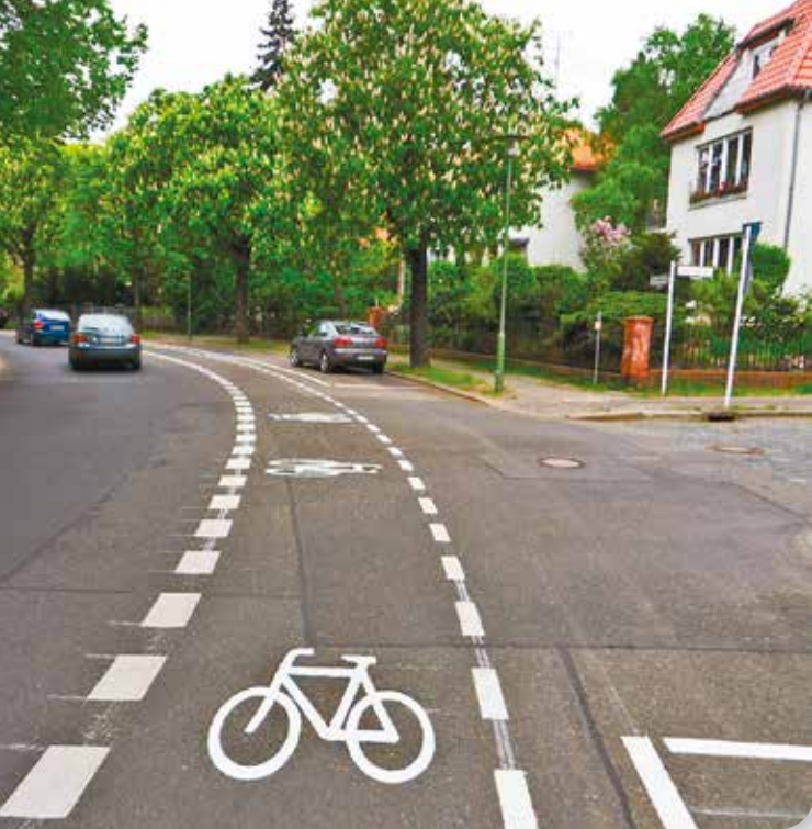
Deutliche Markierung der Radverkehrsführung
